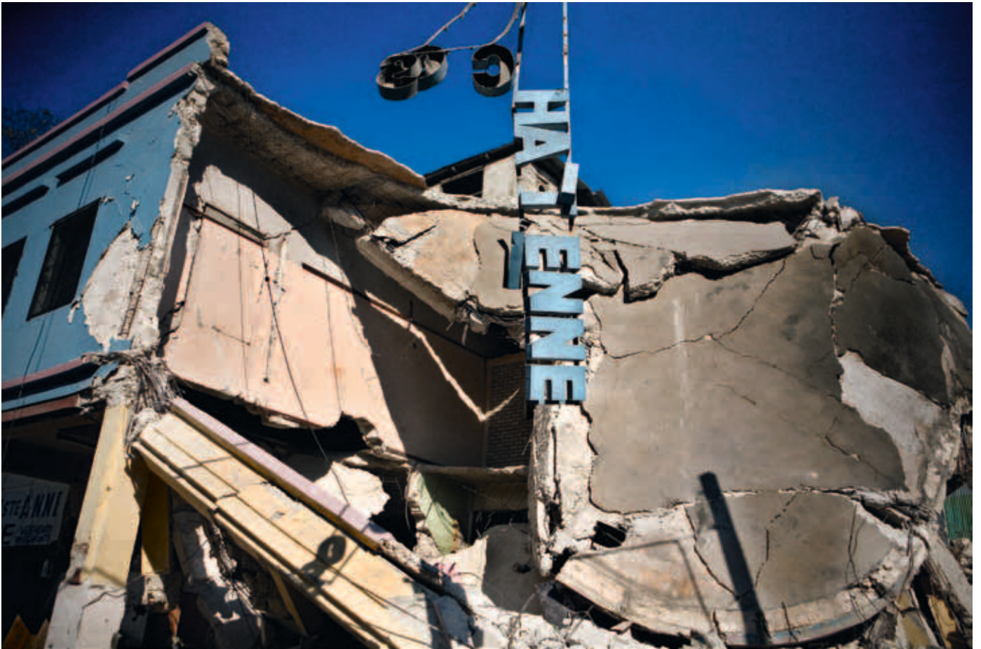
In der Hauptstadt Port-au-Prince ist fast alles zerstört, Häuser fielen wie Pappkartons zusammen.
