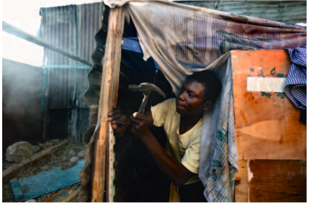
Ein Junge zimmert an einer provisorischen Unterkunft. 1,3 Millionen Menschen wurden durch das Beben obdachlos.
